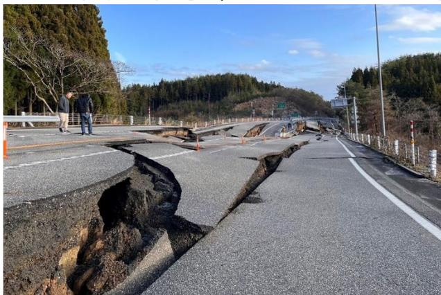
写真：最大震度7を観測した地震でひび割れたのと里山街道
