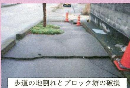
歩道の地割れとブロック塀の破損
